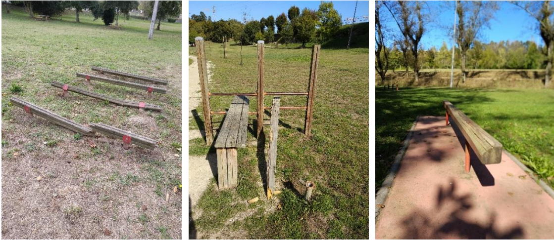
Figura 46, 47 e 48 – Circuito de manutenção degradado (PL Rio Selho, PL Ponte e Parque da Cidade)
