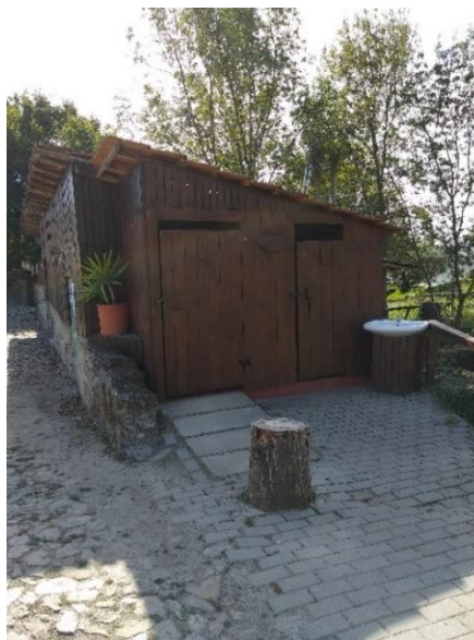
Figura 9 - Instalação sanitária (PL Moreira de Cónegos)
