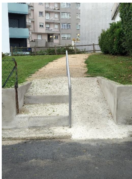
Figura 17 - Acesso com rampa (PL ARCOV)
