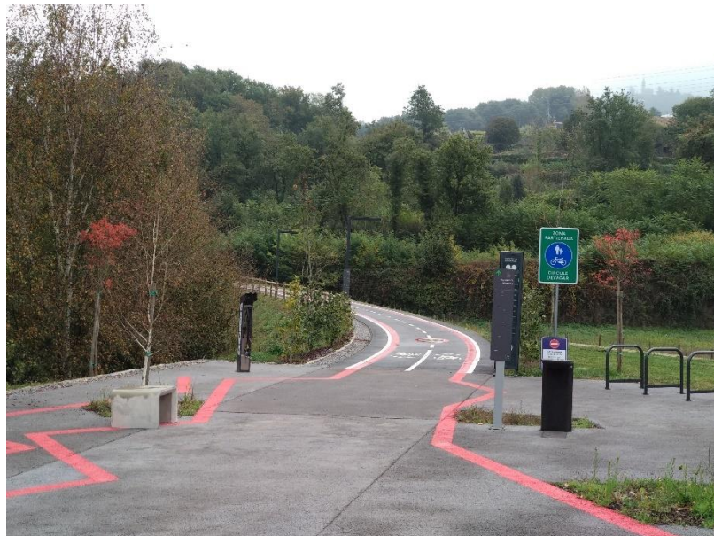
Figura 78 - Ecovia (cimo da Av. D. João IV)
